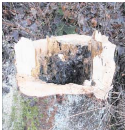
Dieter Lückel geht halbjährlich durch den Park und markiert die Bäume, die gefällt werden müssen. Ist ein ein Stamm so zerfressen, könnte er bei einem Sommergewitter umstürzen.
