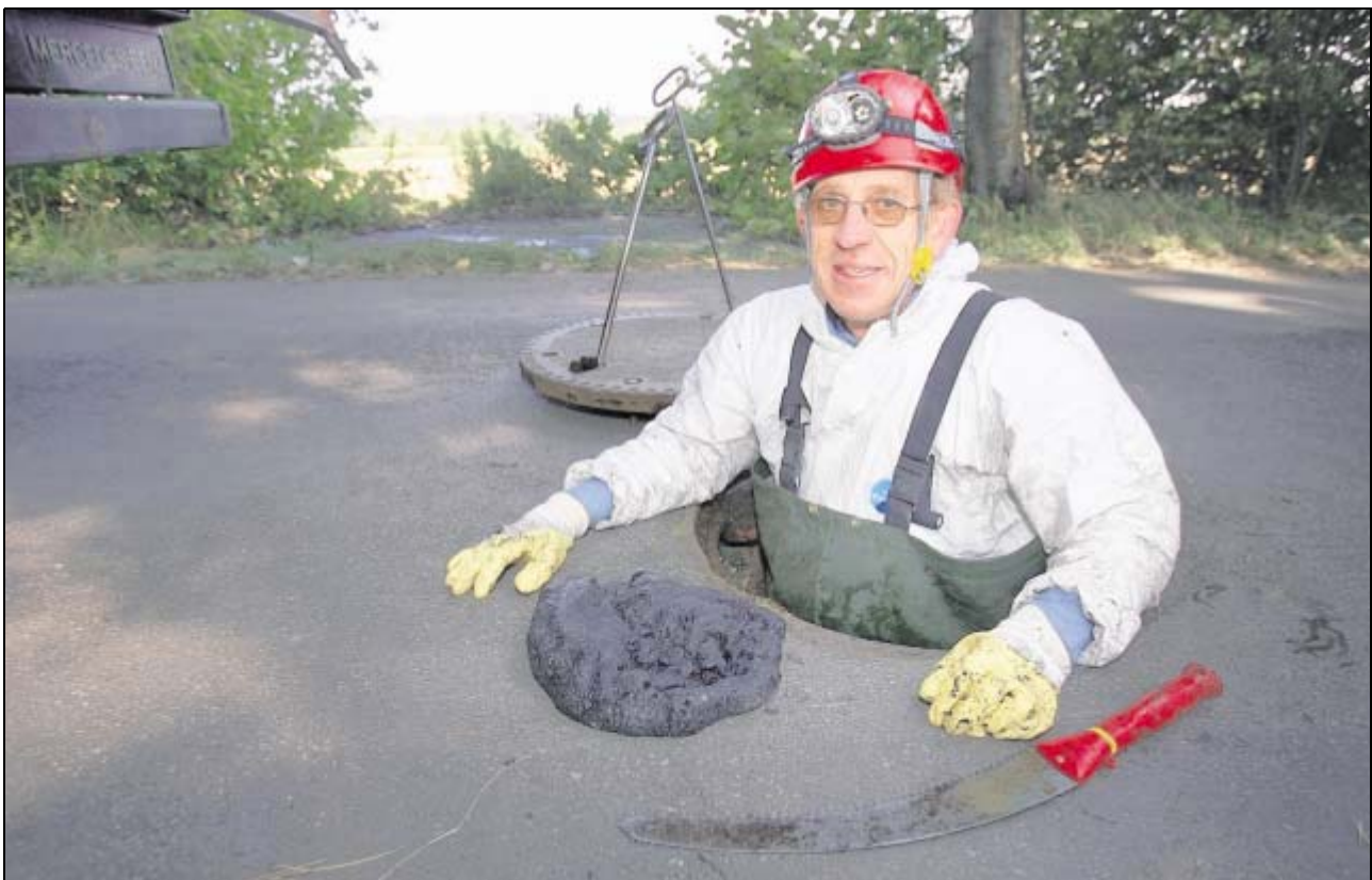
Im alten Kanal 1, am Schwarzen Weg, schneidet Georg Simon drei Stunden lang – nur unterbrochen von kurzen Zigarettenpausen – mit einer Handsäge die Wurzeln ab, die durch Risse in den Kanal hineingewachsen sind. Seit 27 Jahren arbeitet er beim Städtischen Betriebshof. Foto: Marcel Näpel
